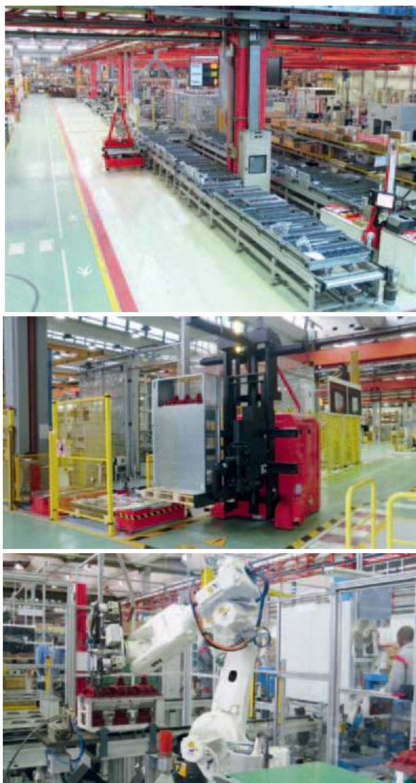
Nelle tre immagini, degli esempi di impianti faro realizzati da ABB.
